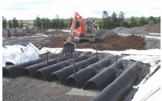
Fig. 15– Backfilling Stone
