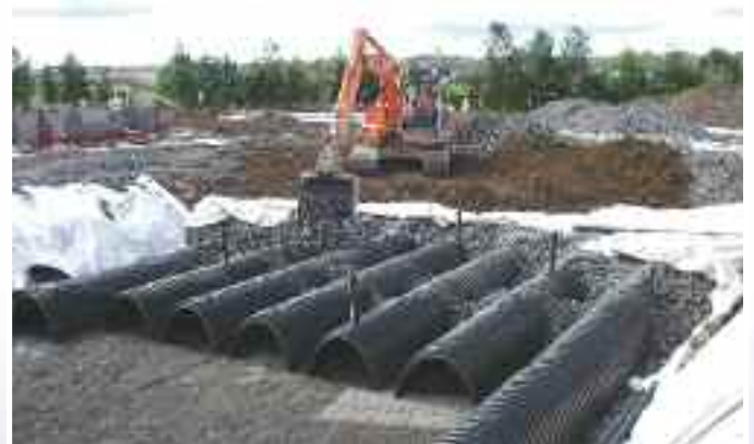
Fig. 15– Backfilling Stone
